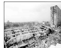
図7 高層ホテルの発破解体解析
