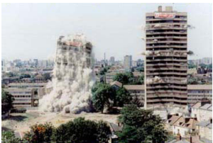
図5 高層建築物の発破解体
