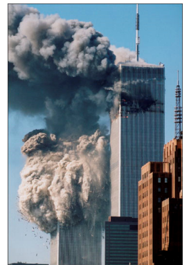
図4 WTC2の進行性崩壊
