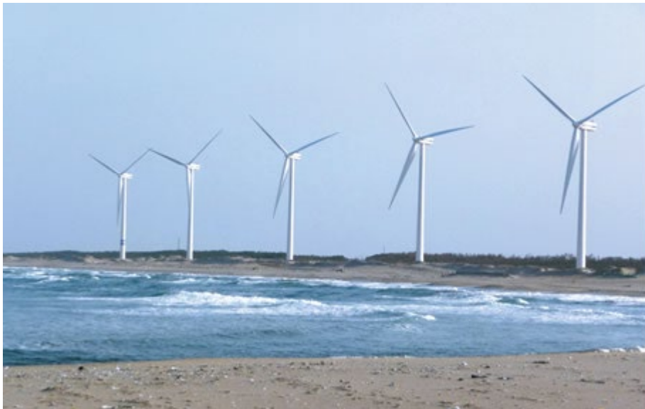
神栖 風力 発電所
