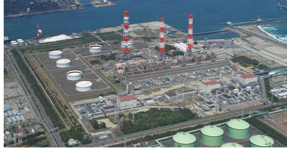
鹿島 火力 発電所
